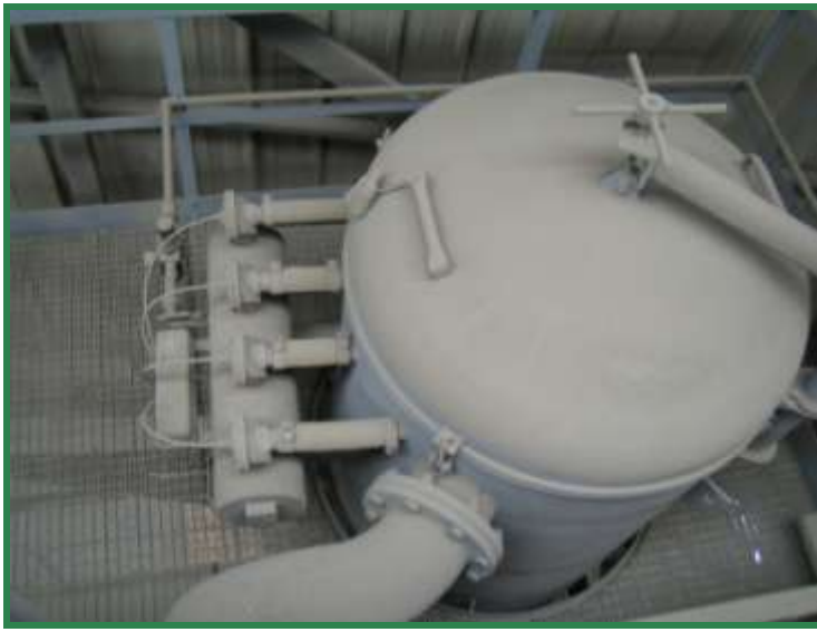
крышка фильтра с люком и рычагом
